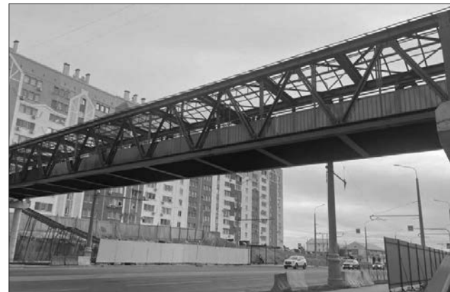
Завершить строительство всех надземных пешеходных переходов на Камышовом шоссе планируется в конце 2023 года.
